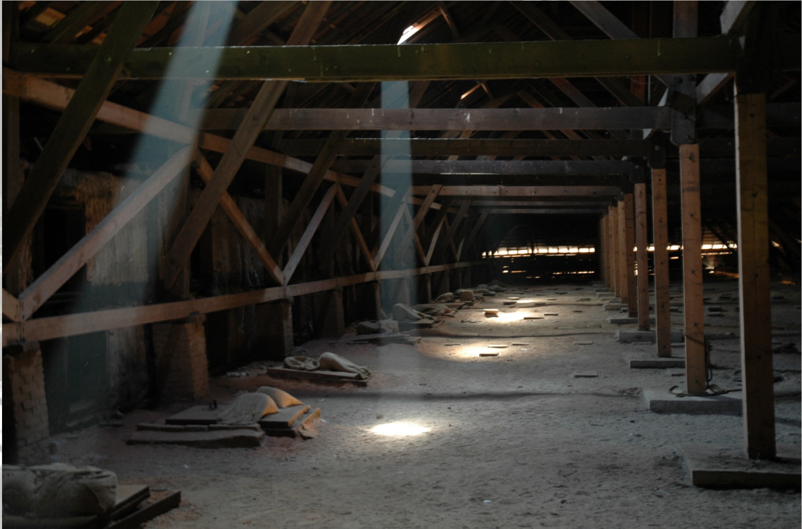
Aan de linker zijde loopt het grote rookafvoer kanaal naar de schoorsteen
