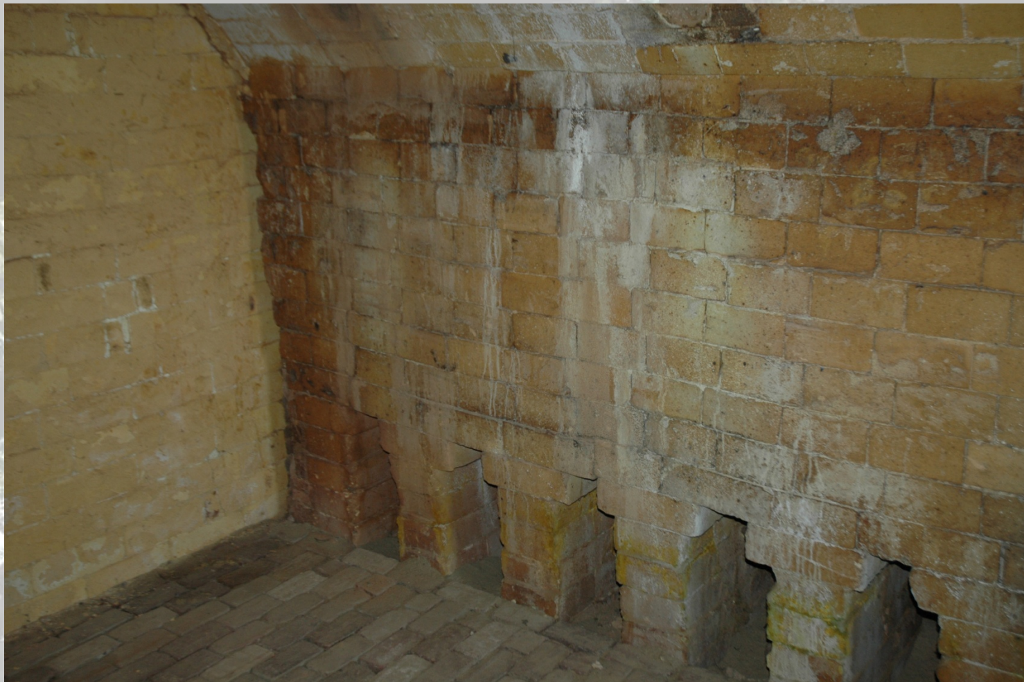
De doorgeefgaten om het vuur te leiden naar de volgende tunnel
