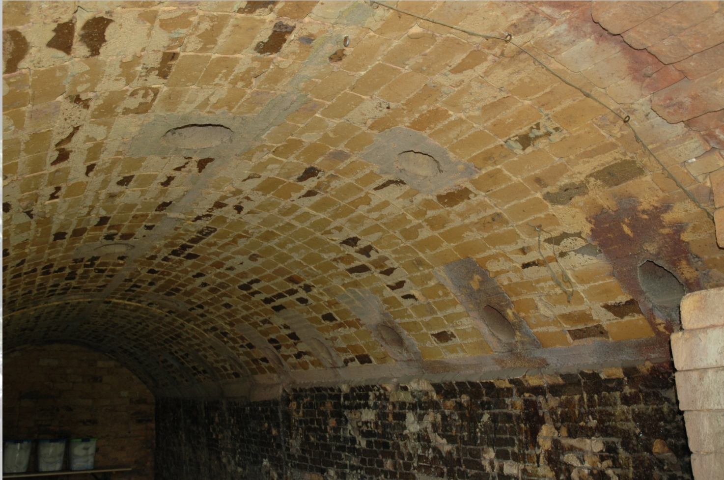
De ventilatie toevoer gaten in het gewelf
