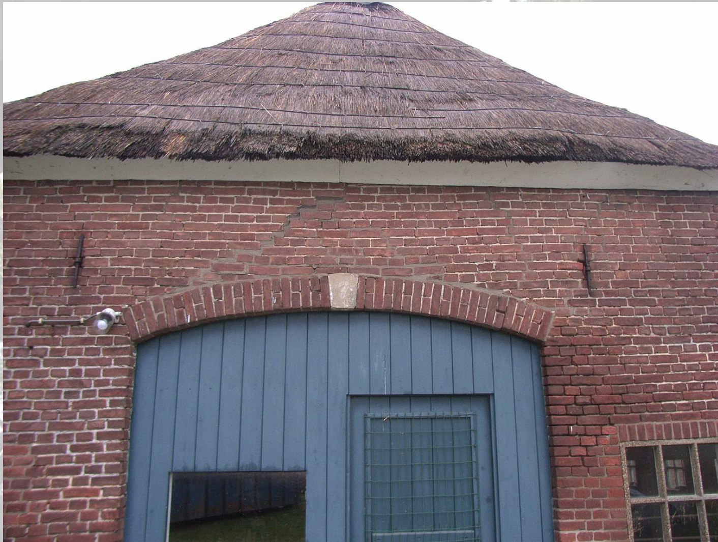
Boven de boog een herstelde scheur
