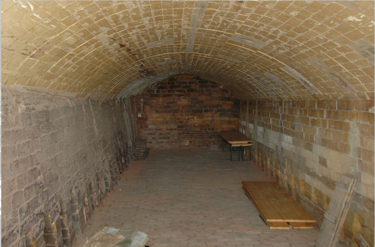
Inkijk in een baktunnel
