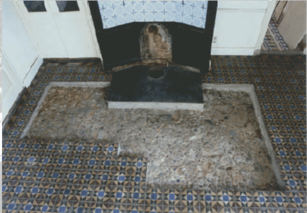
Keitjesvloer onder tegelvloer in Geesteren
