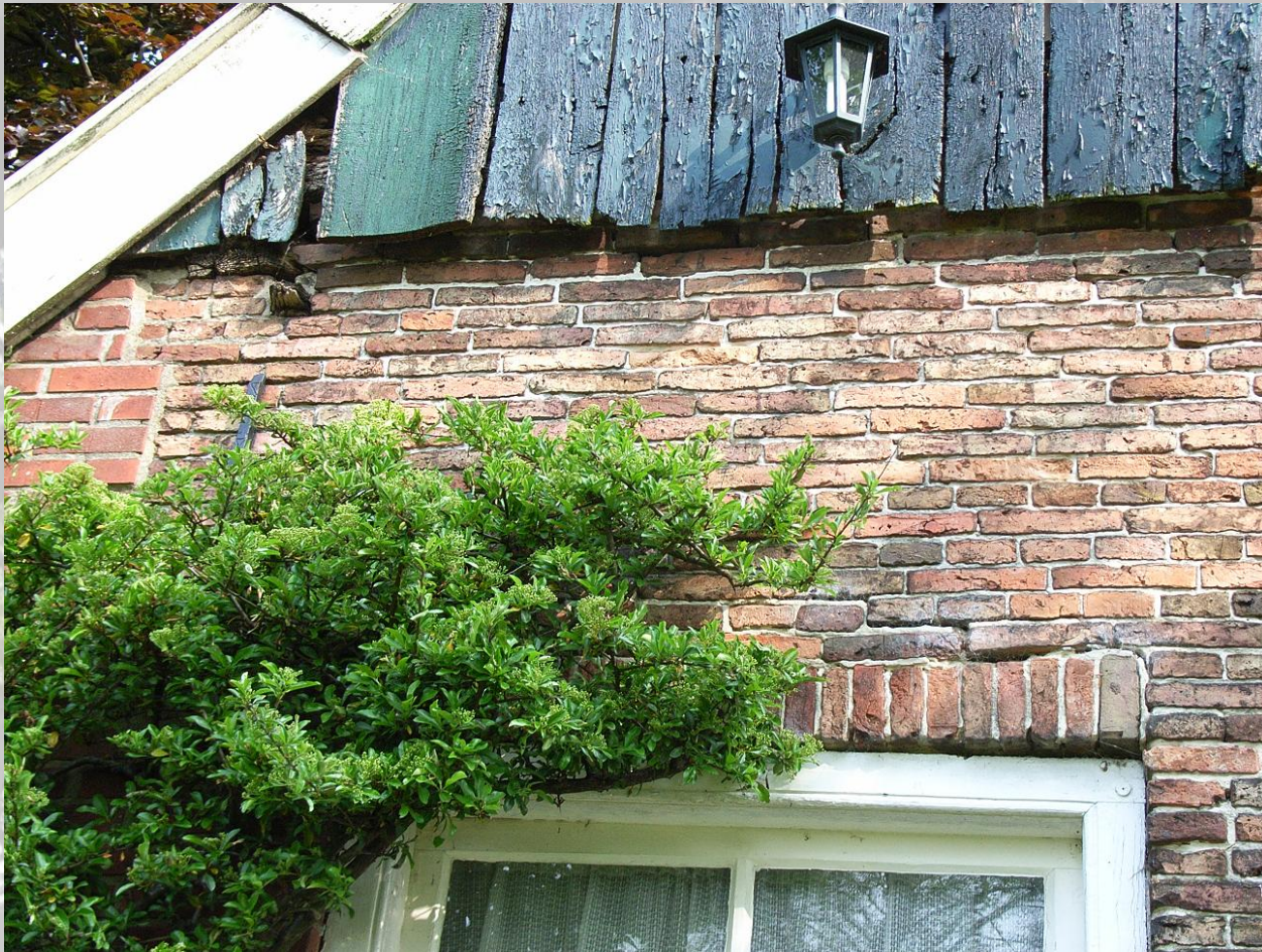
Metselwerk uit het eind van de 18e eeuw met een uitbreiding uit 1970
