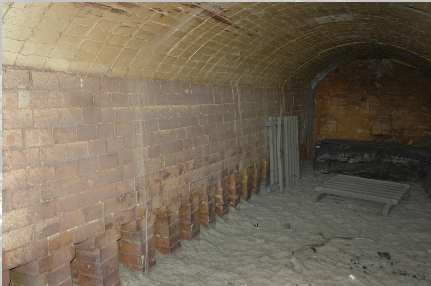
De muren tussen de tunnels voorzien van "doorgeef" gaten
