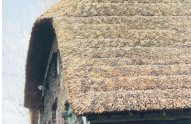
Een opgestopt rietdak. De gaarden blijven zichtbaar
