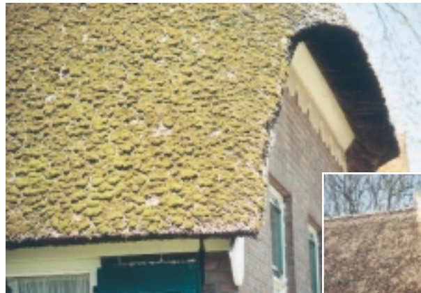
Een zwaar bemost rieten dak in drogende toestand. Volledig droog mos rult op en rolt dan soms vanzelf van het dak
