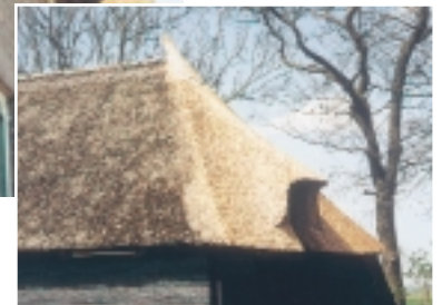
Rieten dak met nok en tuuf van stro
