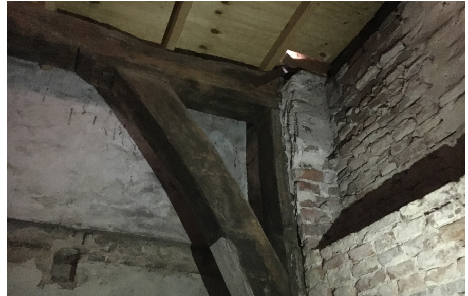
Afb. 21 Eiken ligger met sleutelstuk, muurstijl en korbeel. Rechtsboven de dichtgezette sparing.
