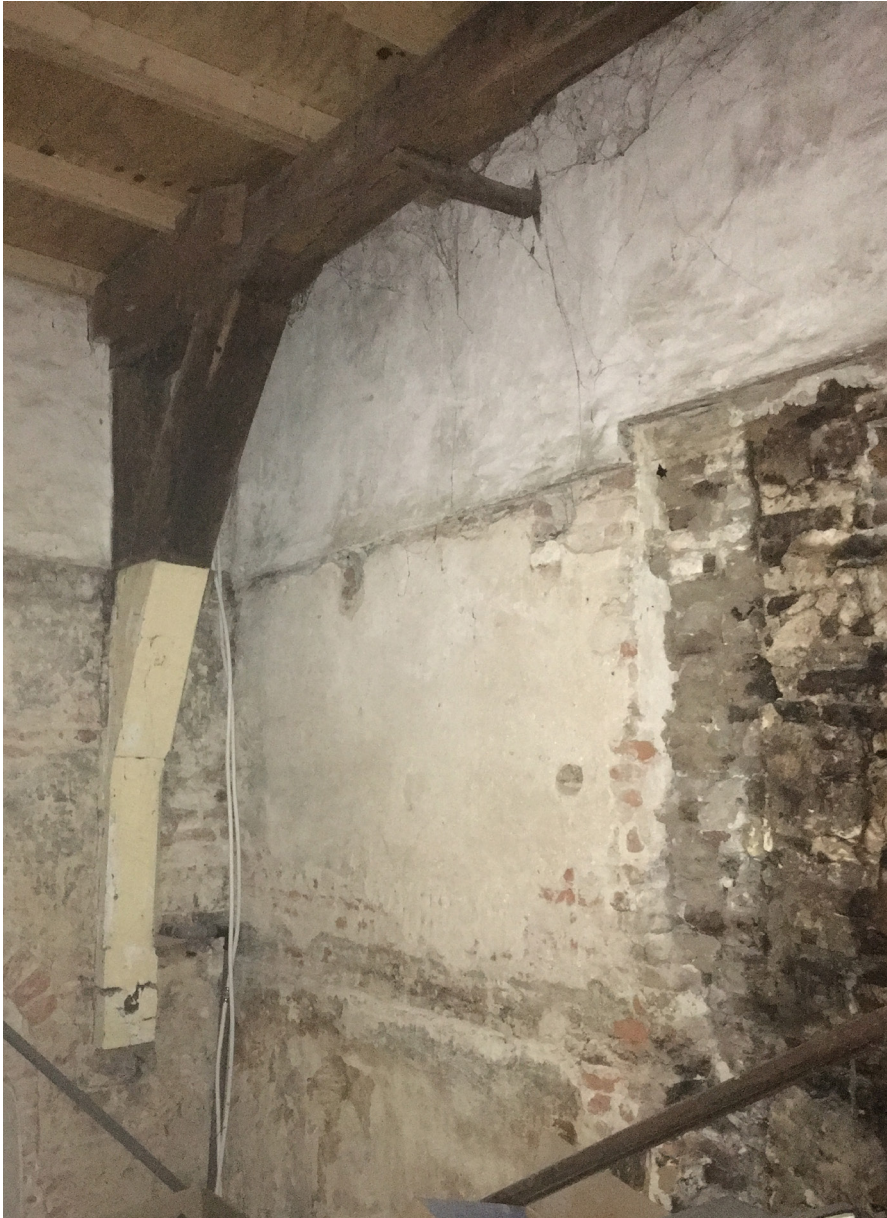
Afb. 20 Eiken ligger met muurstijl en korbeel met de aanzet van een boog ernaast. Eronder bevindt zich de moerbalk. Waarschijnlijk is dit de voormalige buitenmuur geweest.
