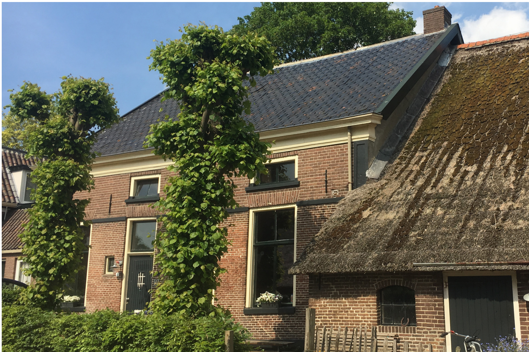
Afb. 6 Rechter zijgevel van het hoofdhuis met de dakbedekking met in Overijssel zeldzame dakpannen.
