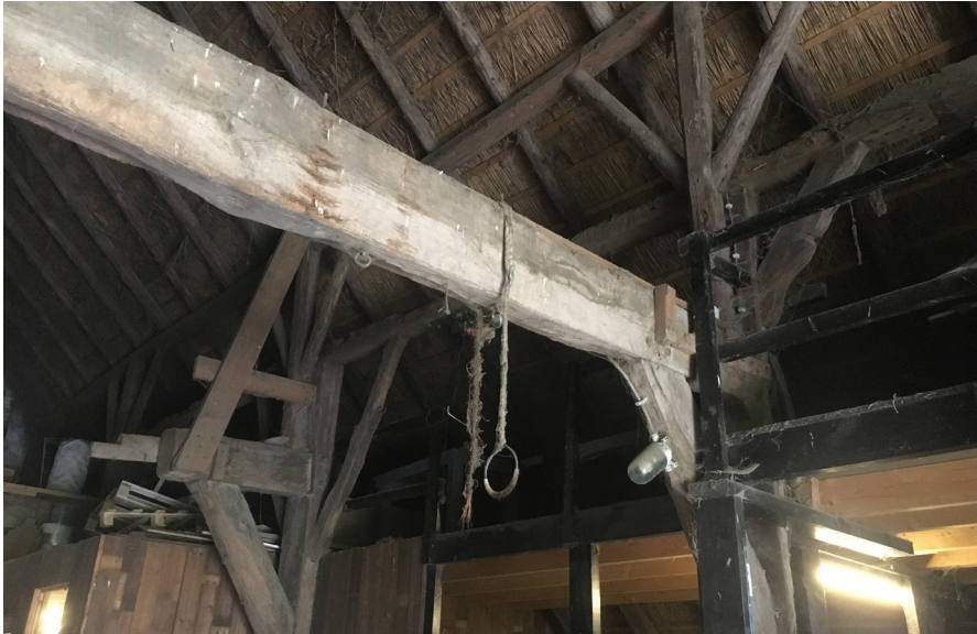
Afb. 11 Aangepaste gebinten op de deel.
