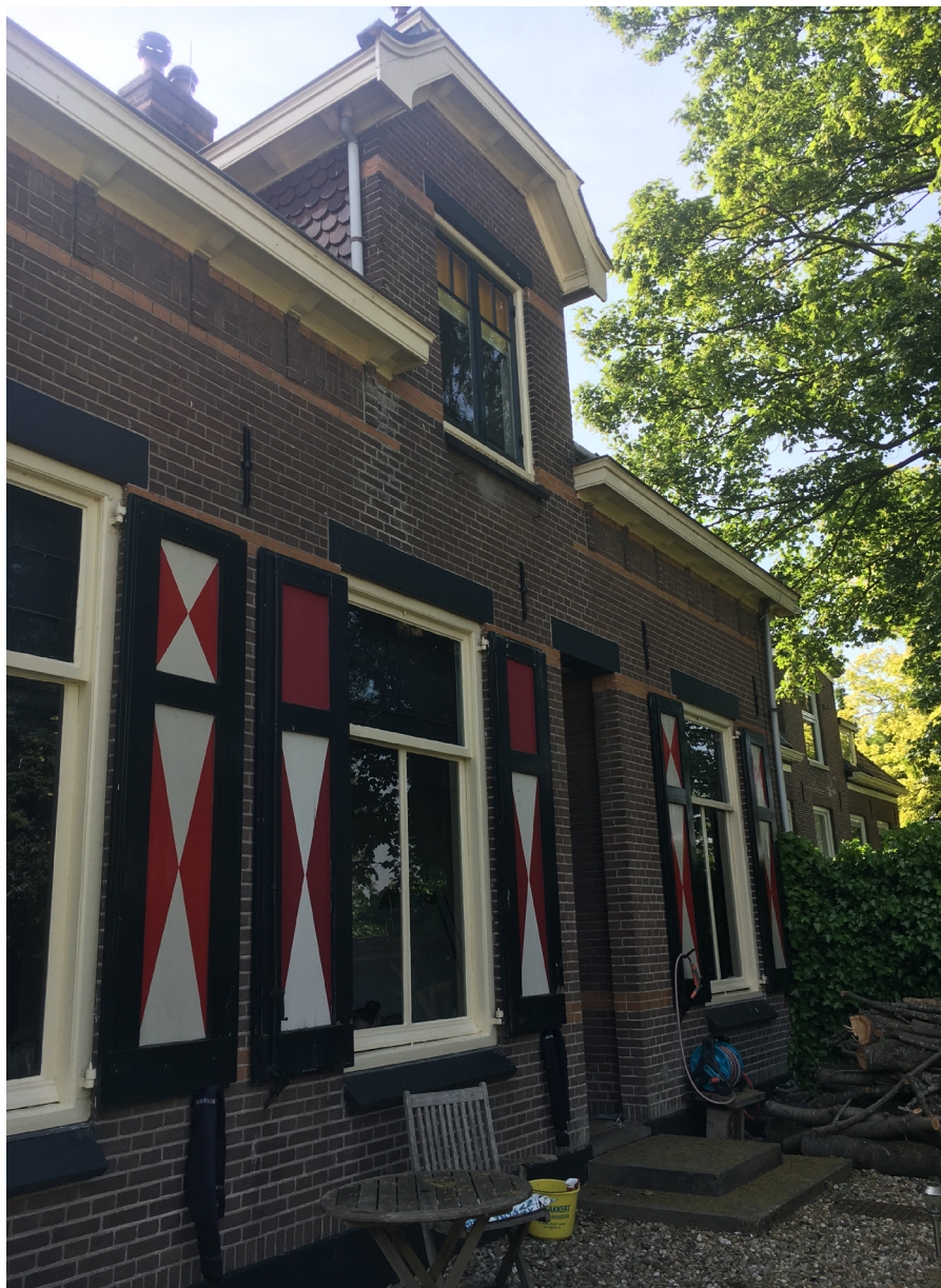
Afb. 7 De andere voorgevel heeft een begin 20ste eeuwse uitstraling.
