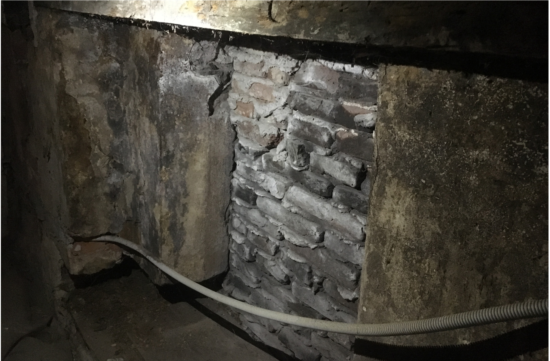
Afb. 15 Dichtgezette sparing met natuurstenen stijlen en eiken latei in een muur van kloostermoppen.
