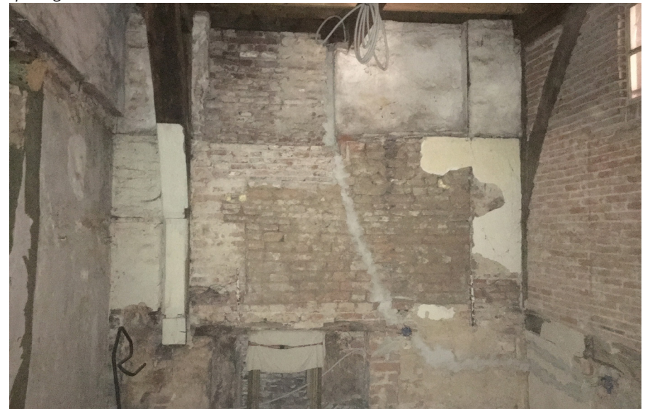
Afb. 22 De andere zijde van de ruimte. Op de linkermuur zijn roetsporen zichtbaar van een rookkanaal met een stookplaats. De achter muur met de twee muurstijlen en ertussen twee dichtgezette sparingen in het metselwerk van kloostermoppen.
