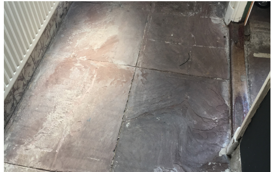
Afb. 14 Dwarsgang met natuurstenen tegels.
