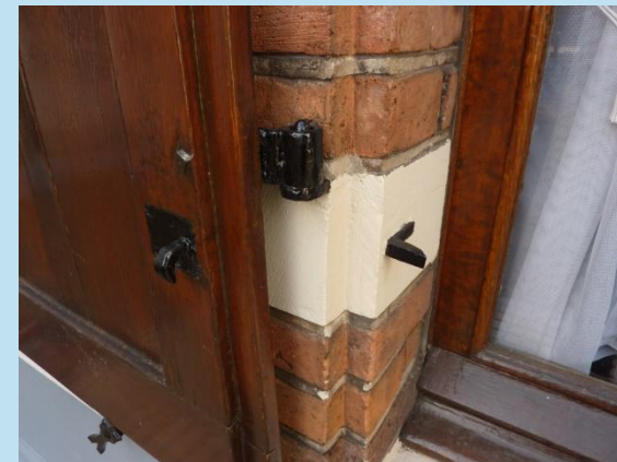
Een detail opname van de borging van de luiken bij een open toestand.
