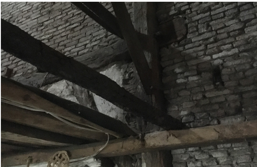
Afb. 14 De gebintligger is opgenomen de brandmuur en niet verlaagd vanwege de omvangrijke bouwkundige gevolgen die dit zou hebben. Op de nieuwe hoogte van de andere gebintliggers is een extra draagbalk aangebracht die de slieten moest dragen.
