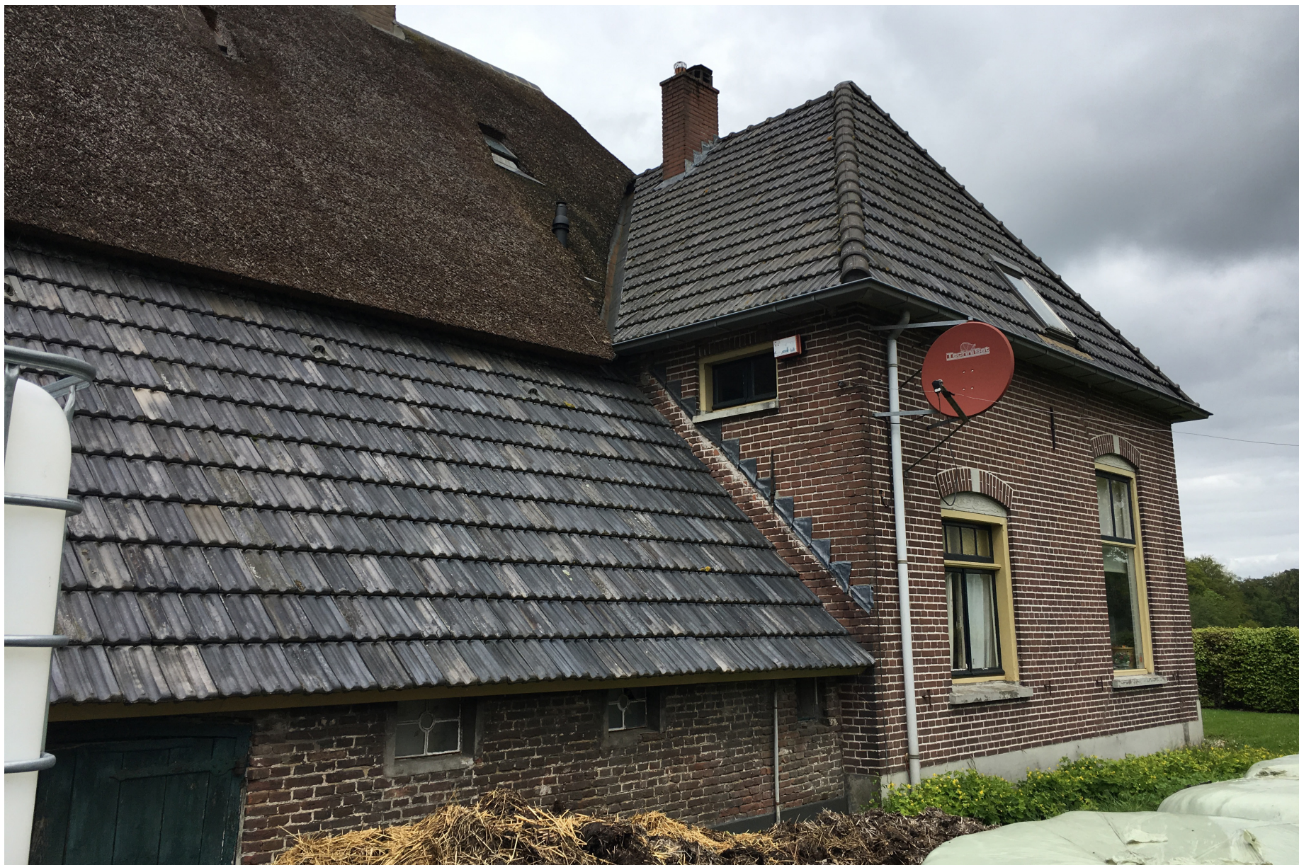
Afb. 5 Aansluiting deel op het voorhuis en zicht op de linker zijgevel.
