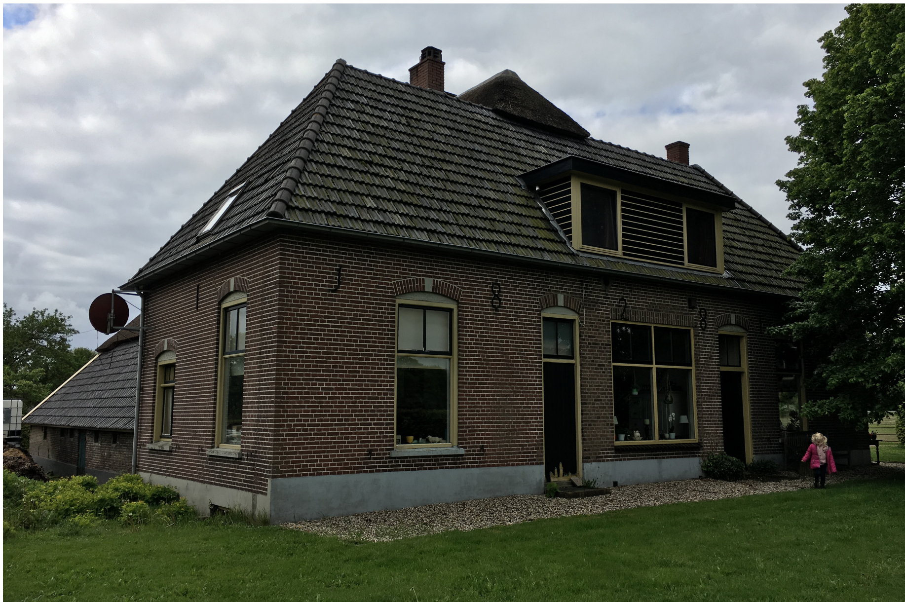
Afb. 4 Voorgevel van de boerderij met de hogere nok van het achterhuis, die over de nok van het voorhuis heen steekt.
