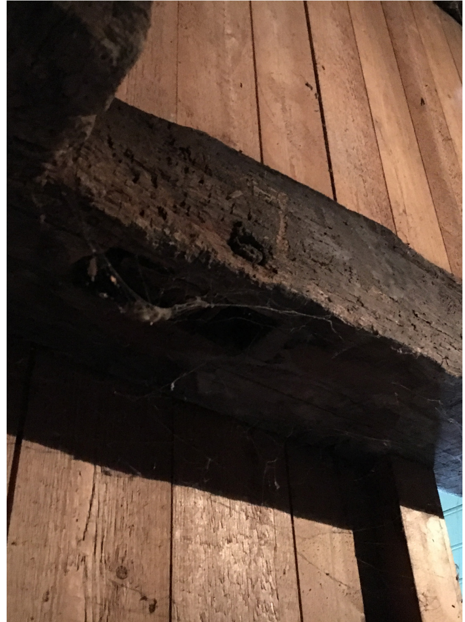
Afb. 13 De linker bovenplaat in het voorhuis. De sparing markeert de plek waar het laatste windverband de gevelstijl koppelde aan de bovenplaat.
