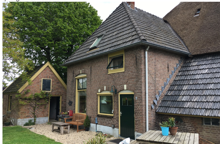
Afb. 16 Rechter zijgevel van het voorhuis. De opzet met achterdeur dateert uit 1960. Het raampje erboven is in een latere fase verbreed.
