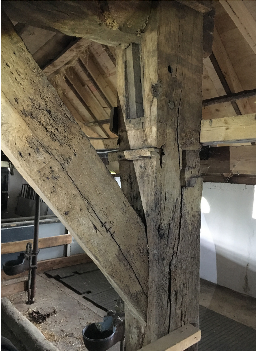
Afb. 12 Telmerk nummer drie is te zien op het verlaagde korbeel.
