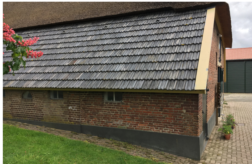
Afb. 15 De rechter zijgevel van de deel, met op circa drie meter vanaf de achtergevel een sprong in het metselwerk.
