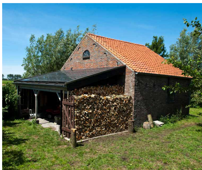
Zonnepanelen op een minder belangrijk bijgebouw
