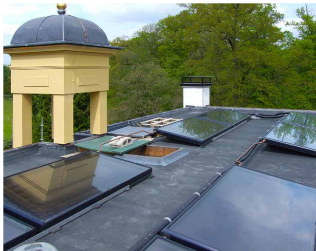
Vlakkeplaatcollectoren voor warmtewinning
