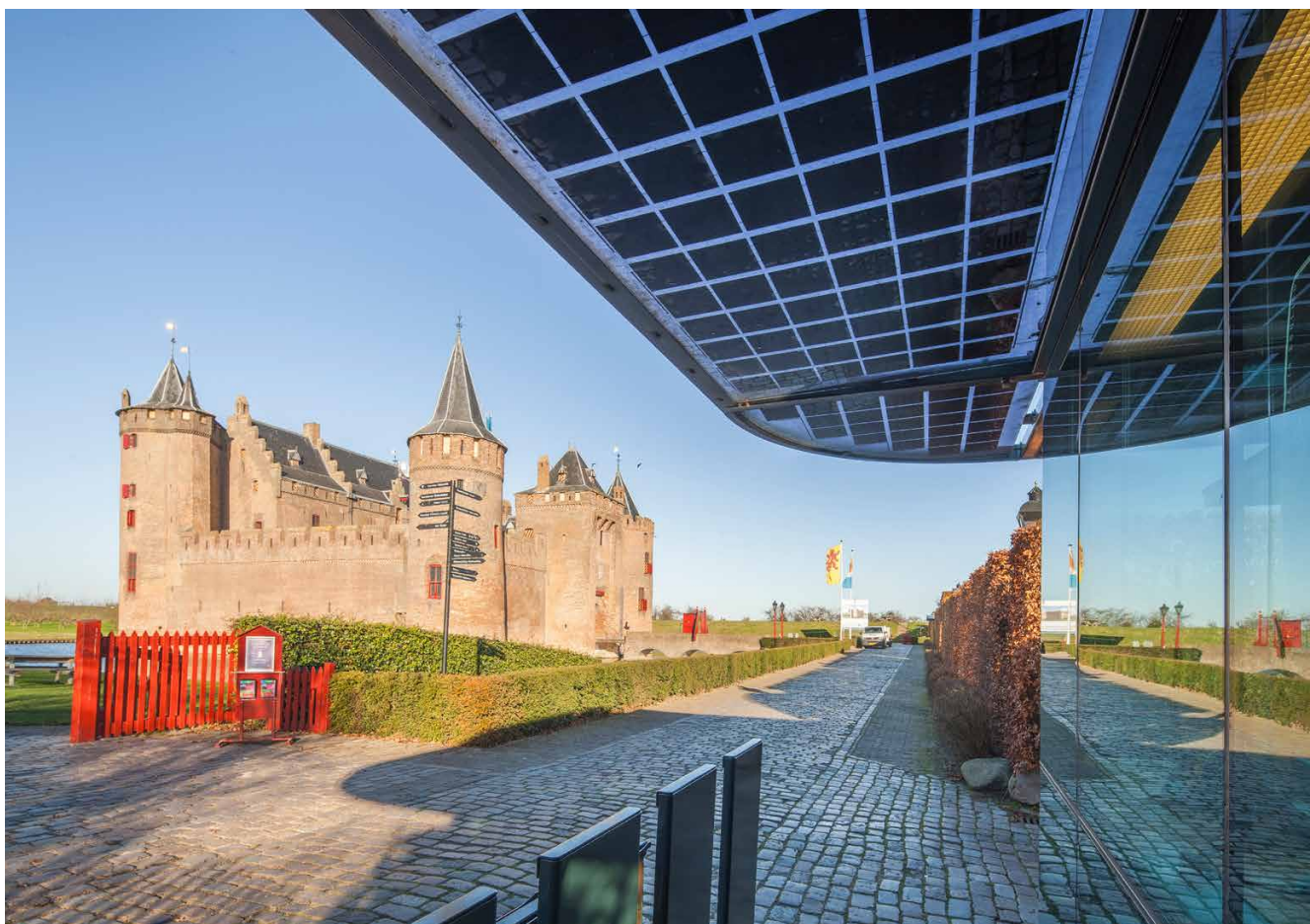
Pv-glas in nieuwbouw op het terrein
