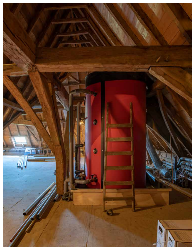
Voorraadvat met warm water – hier extra groot – op een zolder
