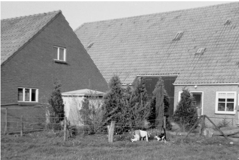
De boerderij met transformatorhuisje
