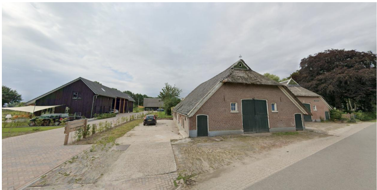
Links de nieuwe schuurwoningen, in stijl en fraai ingepast op het oude erf (foto google)
