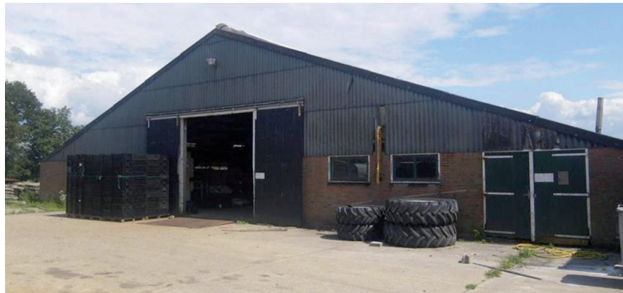
Voormalige agrarische bebouwing in gebruik voor opslag. Bron: www.funda.nl
